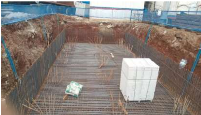
Gambar 5: Foto kerangka rpondasi
