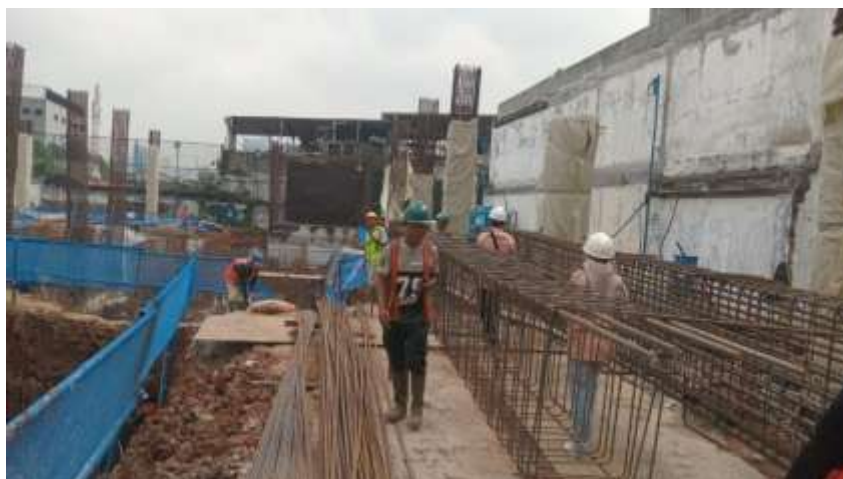
Gambar 5: Foto kerangka rpondasi
