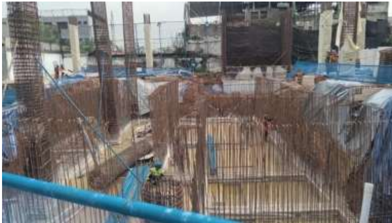
Gambar 4: Proses membangun pondasi
