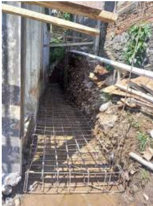
Gambar 12. Proses pemasangan PDT (Penahan Dinding Tanah)
