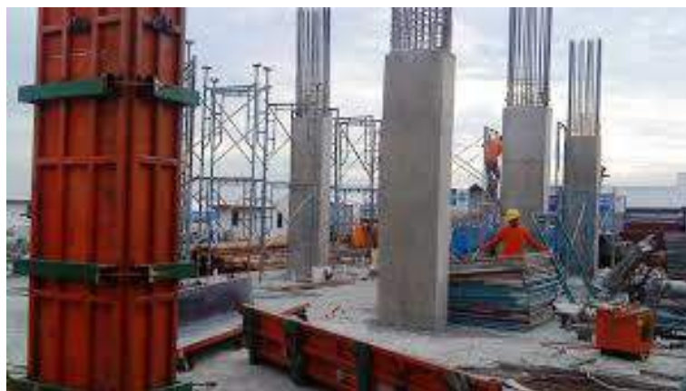
Gambar 6. Kerangka Ring Balok gedung MTsN 14 Jakarta
