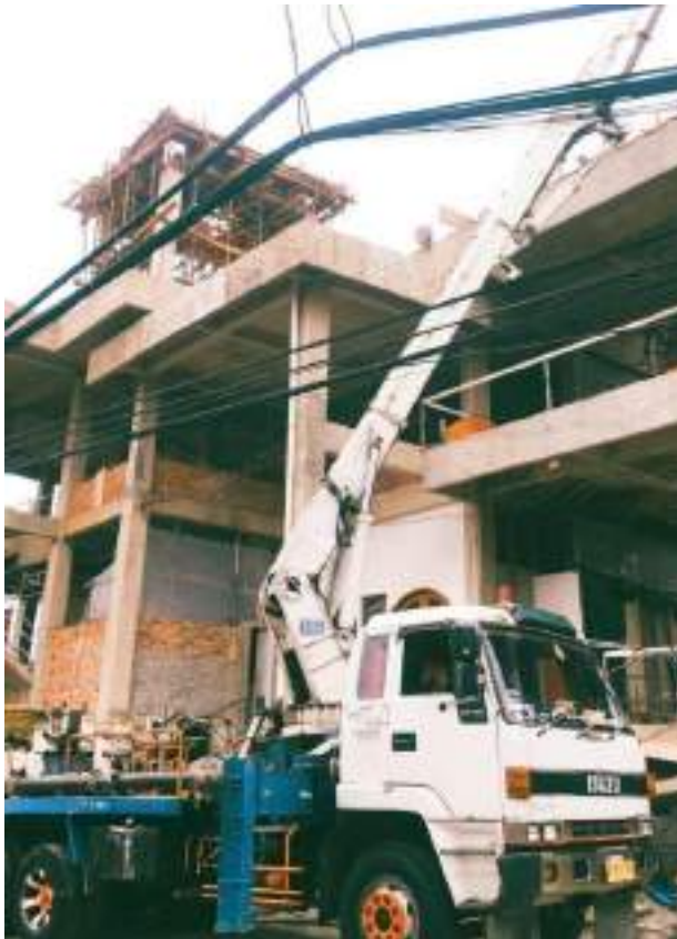
Gambar 5. Proses pemompaan beton pada bagian strutur atas
