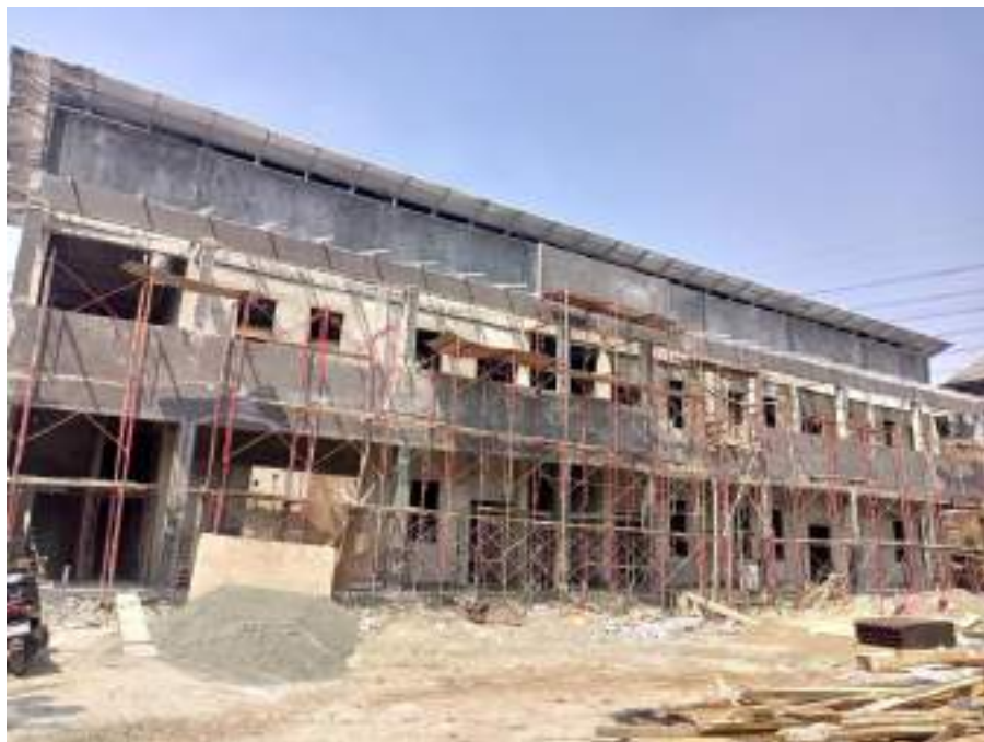
Gambar 1. Penampakan struktur bangunan gedung MTsn 14 Jakarta Timur
