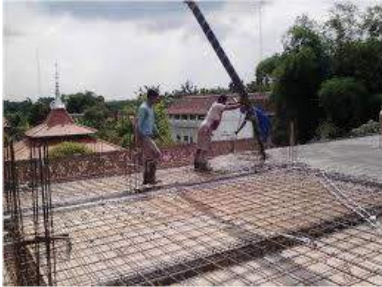
Gambar 11. Proses kegiatan pengecoran plat lantai 2
