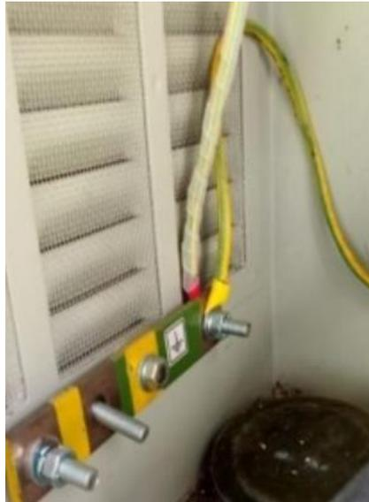
Gambar 2.4. Konstruksi Kabel Grounding
