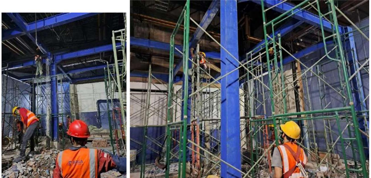
Gambar 6. Rangka Struktur Atas Baja (Kolom & Balok)
