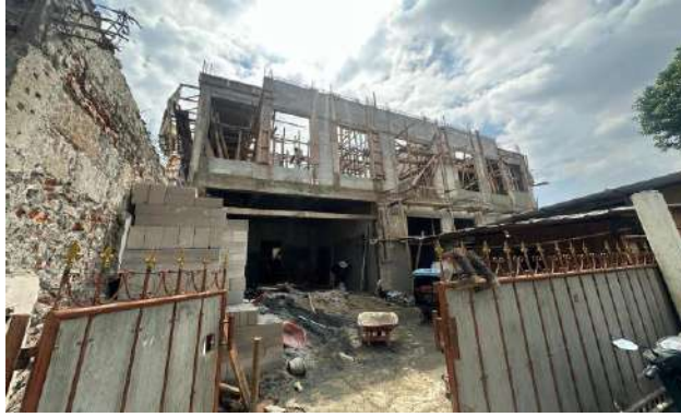
Gambar 1. Foto Penampakan Struktur Pembangunan Rumah Tinggal Pondok Kelapa
