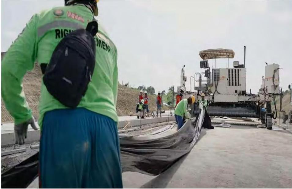
Gambar 4.6 Pemasangan Plastik Hampar Beton
