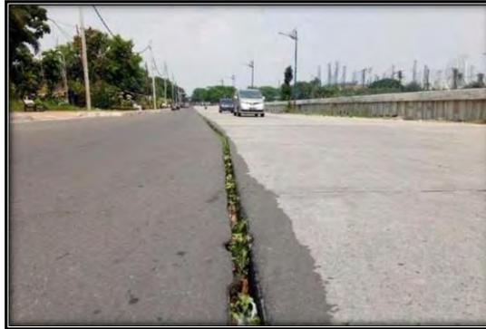
1. Perubahan bentuk (*Deformation*), yaitu perubahan bentuk permukaan ke arah memanjang jalan.
