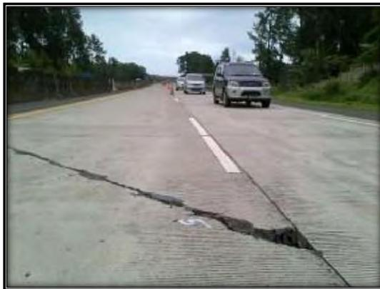
Gambar 3.8 Retak (Crack)
