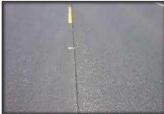
Gambar 3.4 Retak Setempat
