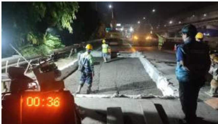
Gambar 14. Proses pemadatan agregat menggunakan baby roller dan stamper
