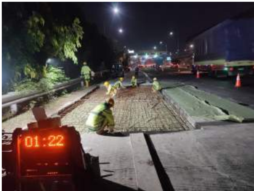
Gambar 16. Pemasangan pembesian
