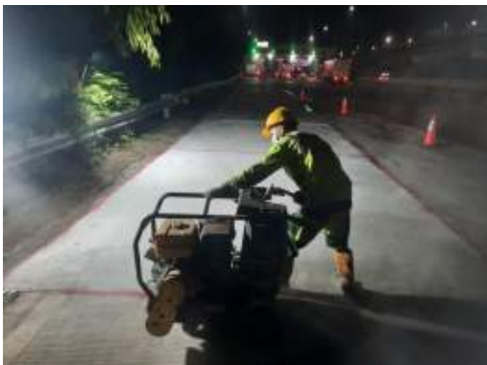
Gambar 19 & 20. Proses cutting joint beton dan sealant pada joint yang telah dicutting
