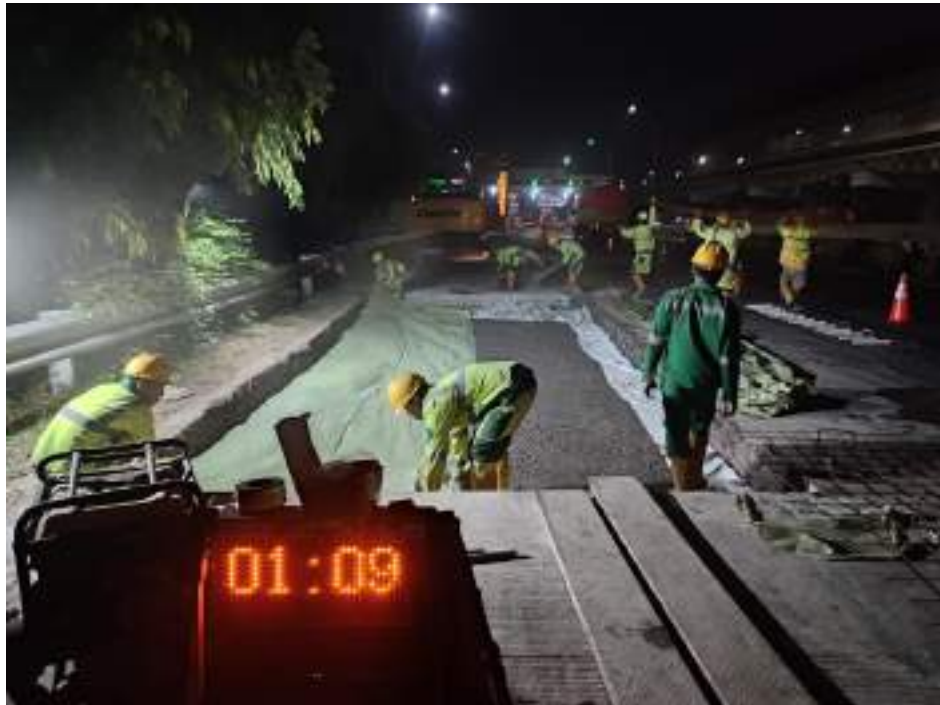
Gambar.15 Proses Pemasangan Plastik Cor
