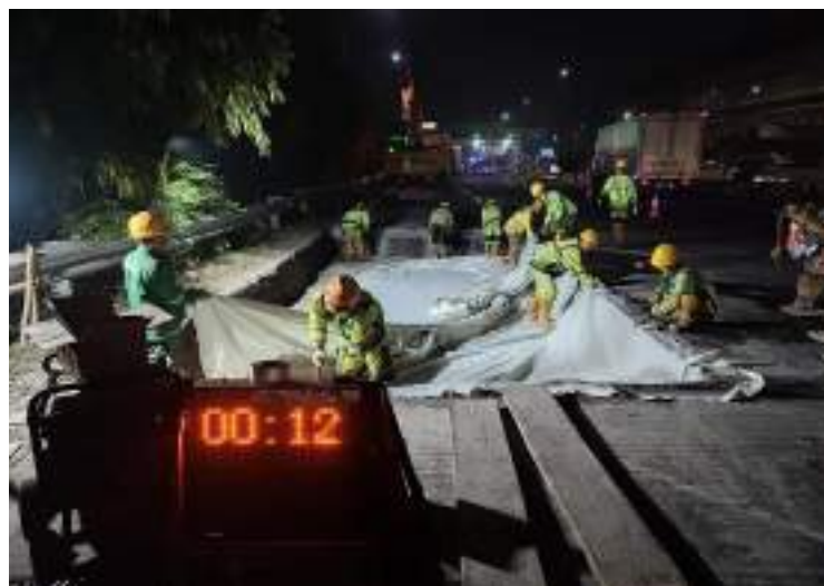
Gambar 12. Proses pemasangan geotekstil
