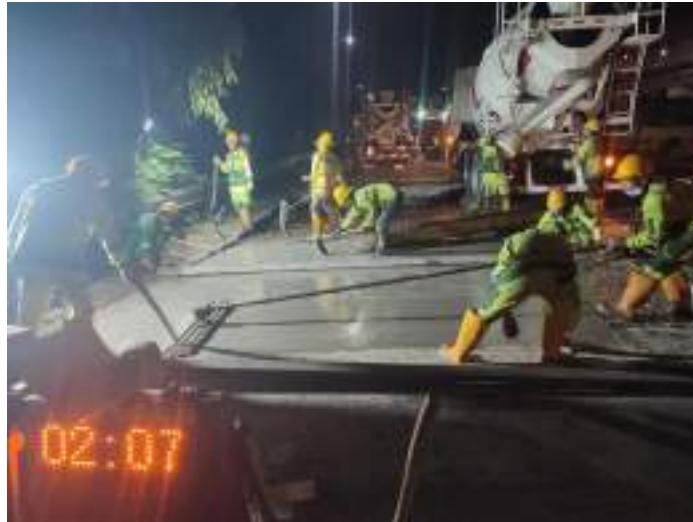
Gambar 17. Proses Pekerjaan Pengecoran
