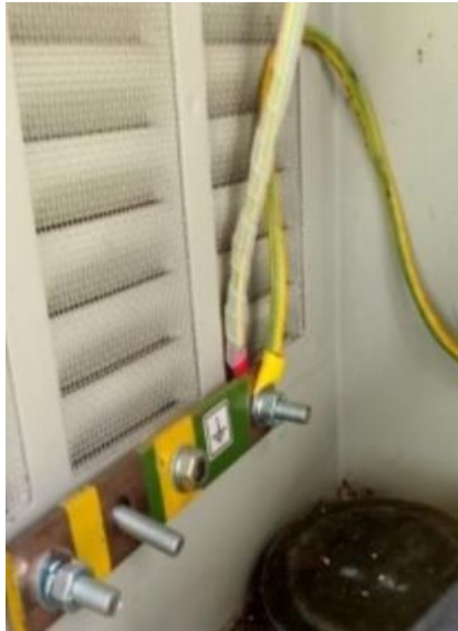
Gambar 2.4. Konstruksi Kabel Grounding
